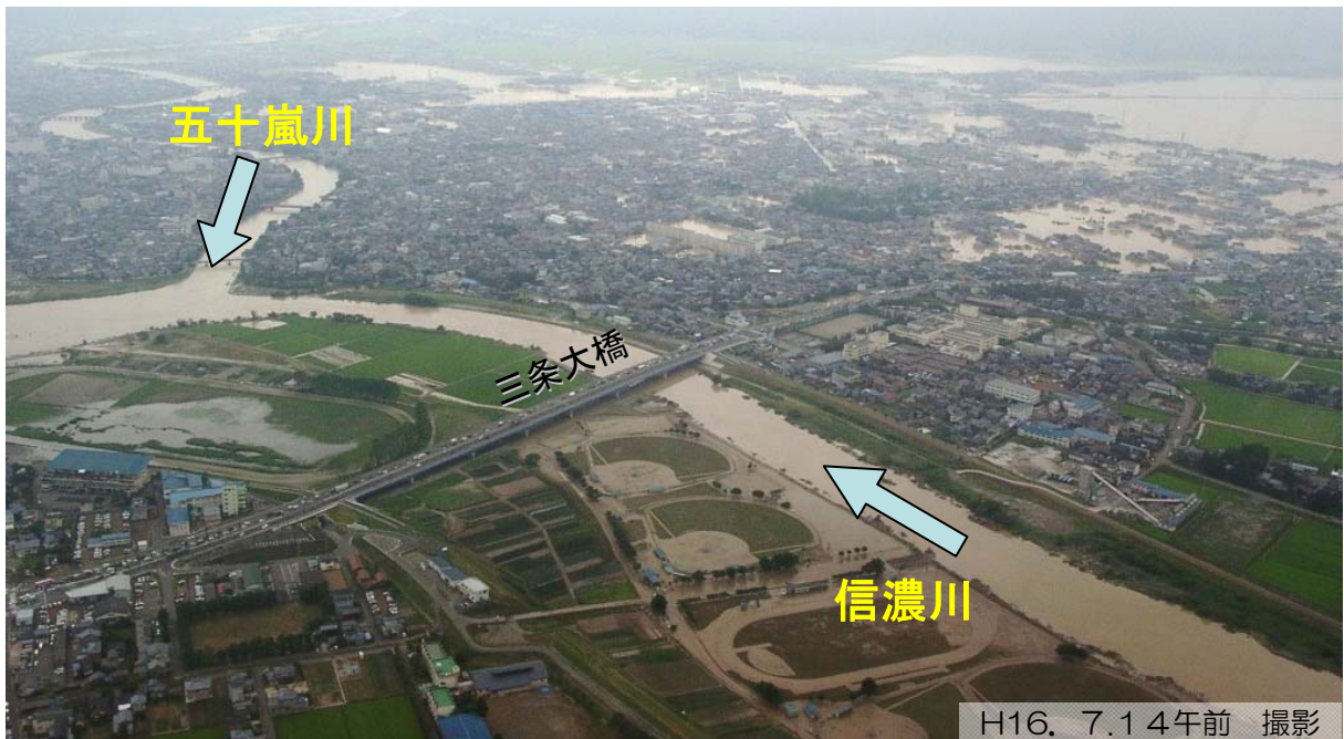
平成16年7月出水状況（三条大橋付近）
