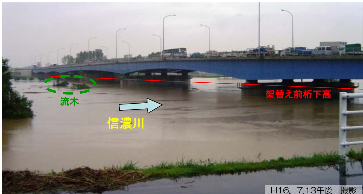
平成16年7月出水状況（三条大橋右岸上流より撮影）
